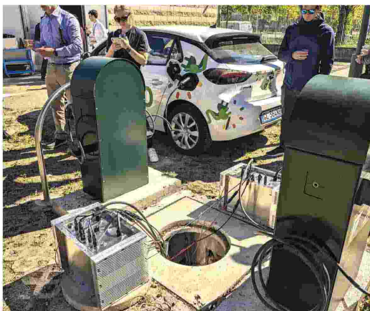
Convertitori per la ricarica DC da 3kW estratti dalla loro sede interrata
